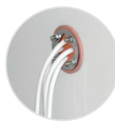
Percement pour passage de câbles PEXTBALI
